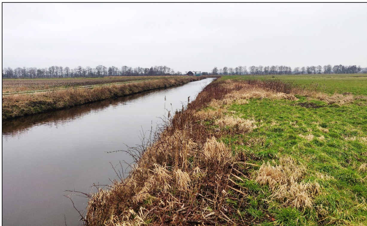
Abb. 19: Böschung im Süden am Meedekanal, Blick Richtung Schöpfwerk.
